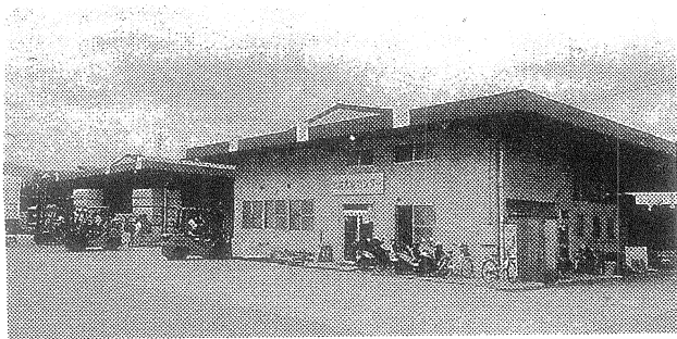
CADセンターを設置した向日町営業所（京都府向日市）
